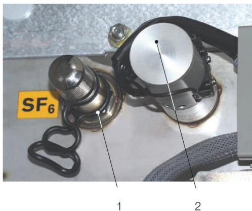
Obr. 7.12.1: Konektor pro plnění plynu (1) a čidlo hustoty plynu (2)
