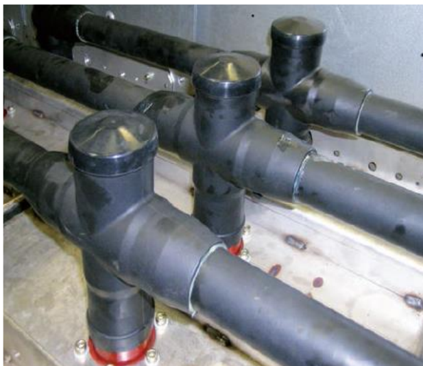
Obr. 7.4.1: Přípojnice s příčnými a koncovými adaptéry
