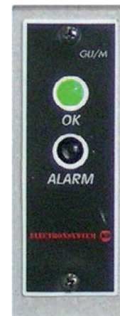
Obr. 7.12.2: Signálka indikující hustotu plynu (je použito v aplikacích, kde tento signál není integrován do ochranného zařízení)
