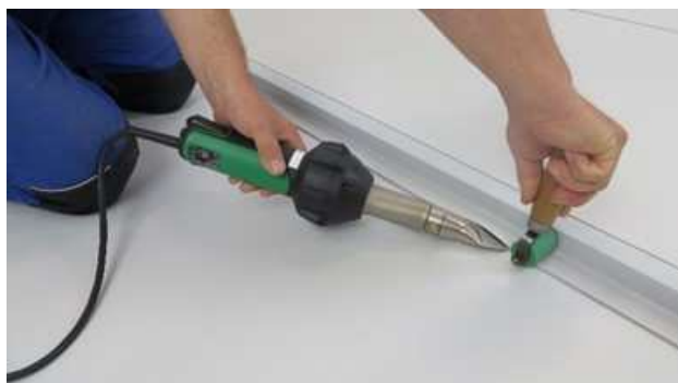
Obr. 25: Navařování profilu ručním svařovacím přístrojem
