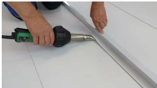
Obr. 6: Bodové přichycení zkušebního profilu k podkladu
