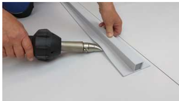
Obr. 23: Fixace profilu druhým bodovým svarem
