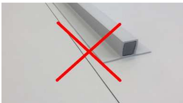
Obr. 19: Vadná instalace – navařený profil umístěný na okraj vrchního pásu hydroizolační fólie nad kotevní řadou
