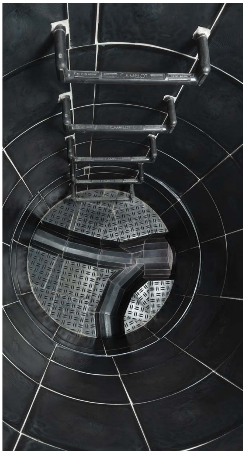
Vnitřní obklad spadišťové šachty čedičem
