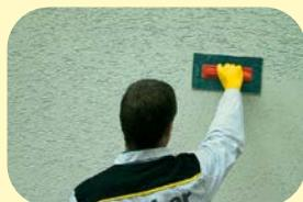
Struktura se vytváří plastovým hladítkem ihned po nanesení. Tahy hladítkem musí být stejnoměrné v celé ploše, zvláště v místech koutů, úrovní podlážek lešení apod.
