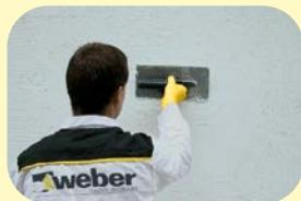
Omítka se nanáší na podklad nerezovým hladítkem na sílu vrstvy danou velikostí zrna. Omítka je třeba napojovat ještě před jejím zavádnutím takzvaně „do živého“. Ucelené plochy provádět bez přerušení.
