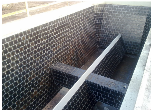
Obložení hlubinného zásobníku na uhlí
