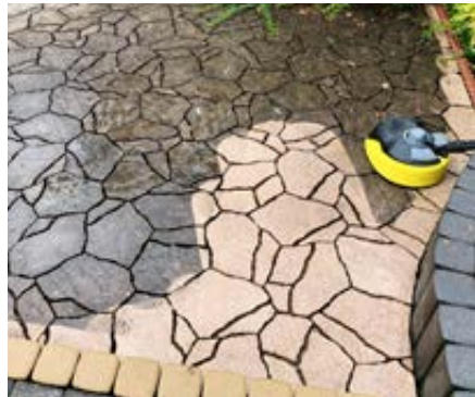
ČIŠTĚNÍ POVRCHU A IMPREGNACE
