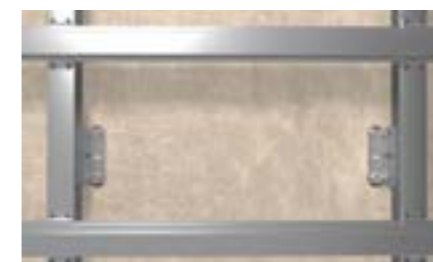
Metal façade substructures
