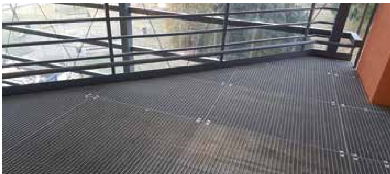
Osově rozteče nosných a rozpěrných pásů u standardního rozměru oka
