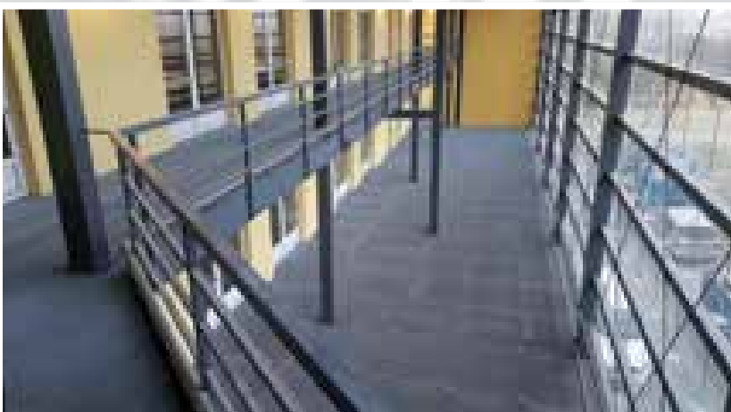
Zakrytí podlahových ploch
