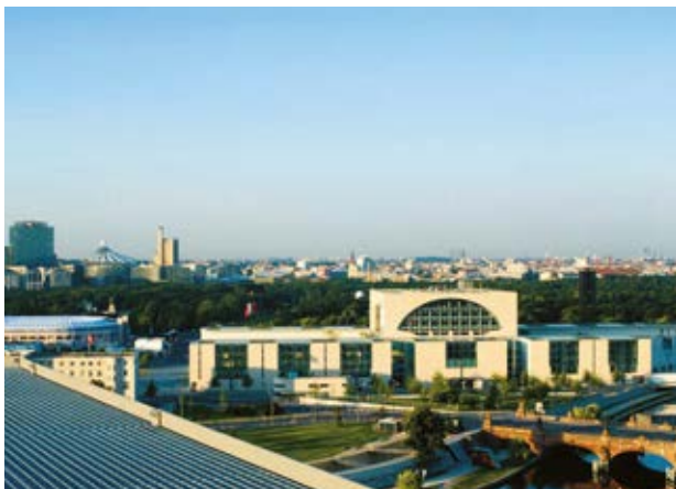
Oben: Hauptbahnhof Berlin Dachbelegung mit Pressrosten im Bereich der Technikzentrale
