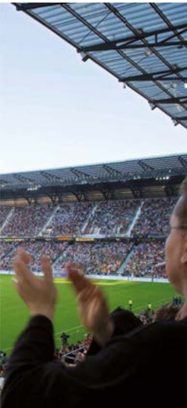
Oben: Stadien Salzburg, Innsbruck, Klagenfurt Patentiert, modulare Tribünensysteme zur EM 2008 geliefert und teilweise montiert
