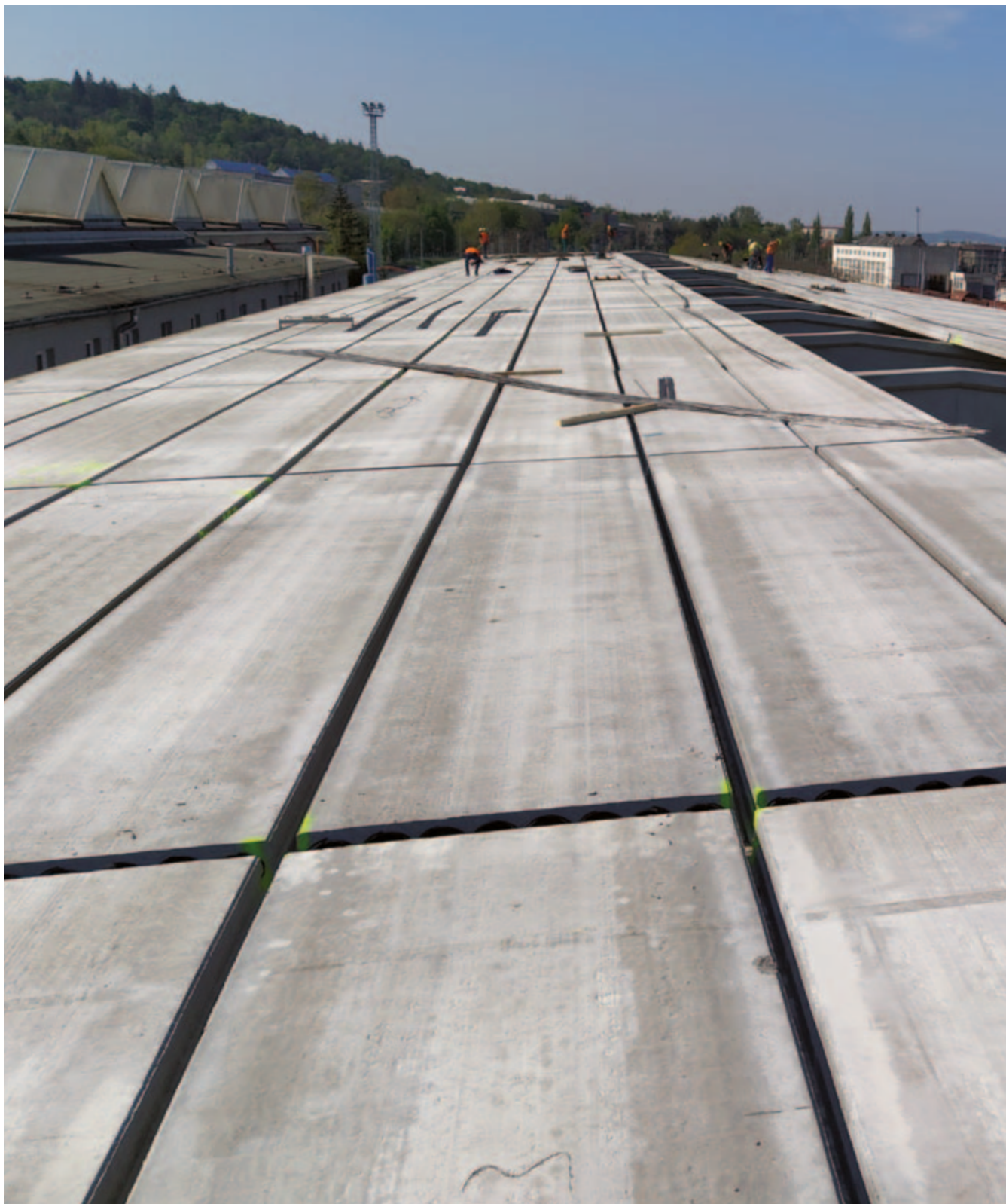
Výstavba haly Juta - Žireč
