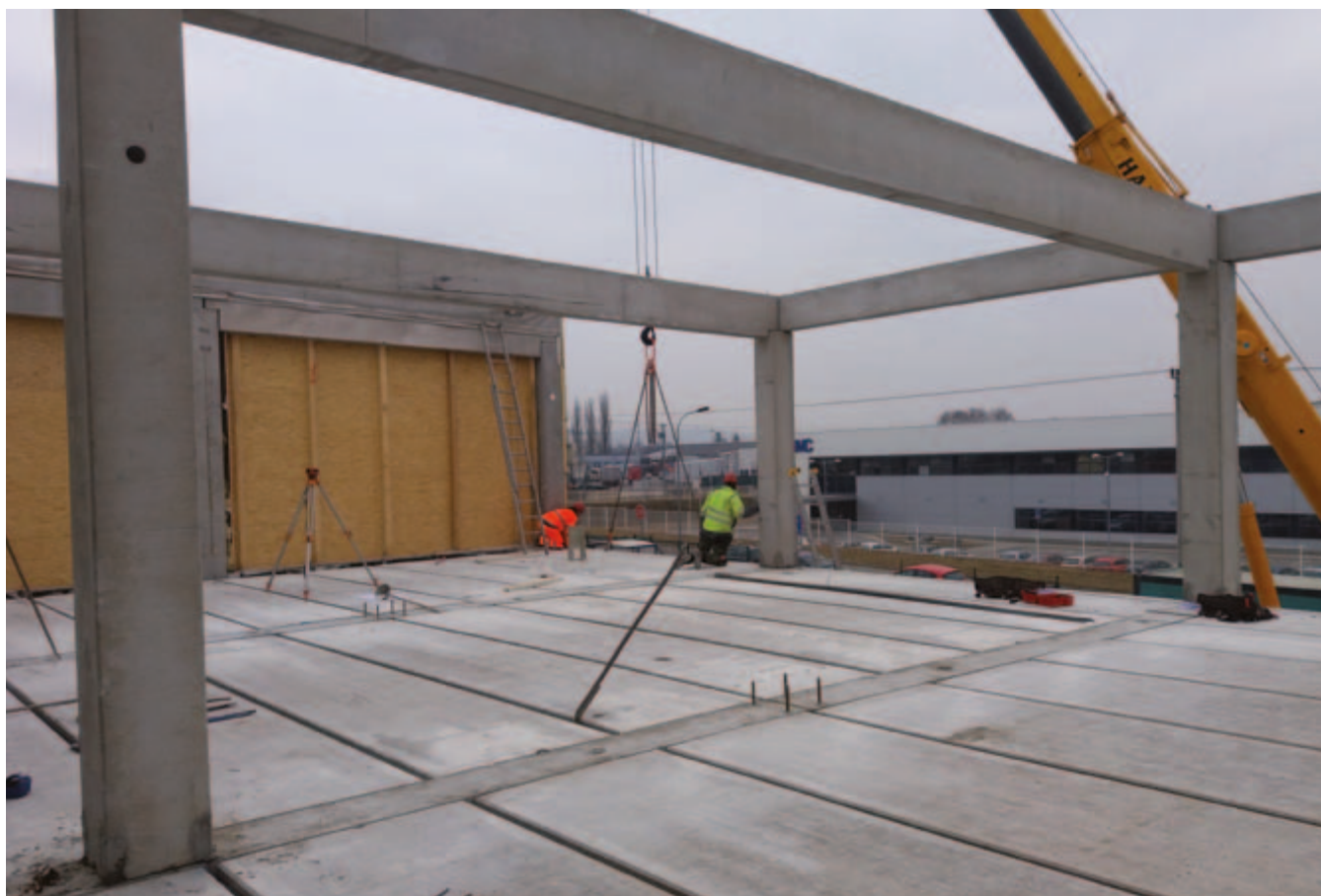
Výstavba haly - Jinačovice
