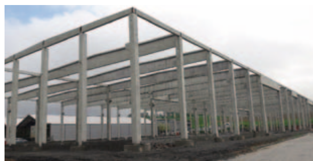
Výstavba železobetonové haly
