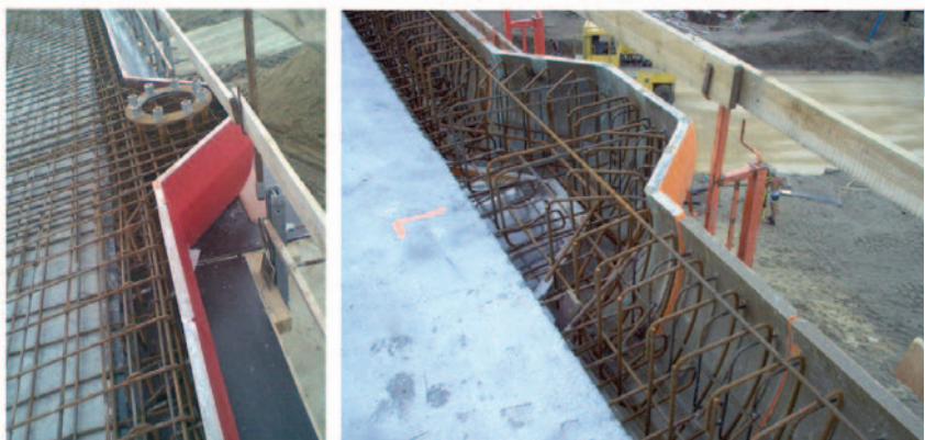
Instalace mostních říms včetně přípravy lávky a výklenků pro osvětlení.
