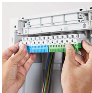
11 Svorkovnice s rychlosvorkami N/PE se jednoduše západkově uchytí natlačením z přední strany do rozvodnice; navíc pak kabely je možno uchytit příchytkami k držáku/ k hřebenům pro odlehčení tahu
