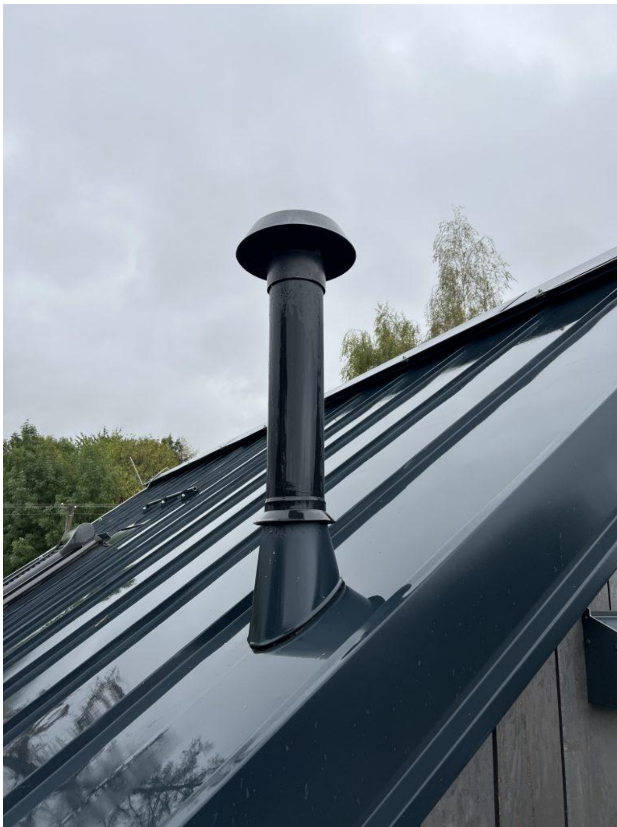
Obrázek 3: Větrání nad střechou
