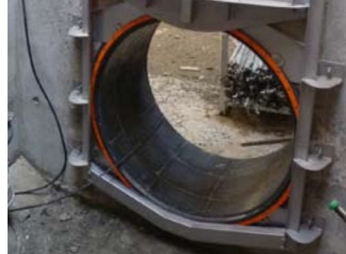
Obr. 6 Prstenc z kalibrovaných radiálních tvarovek z taveného čediče
