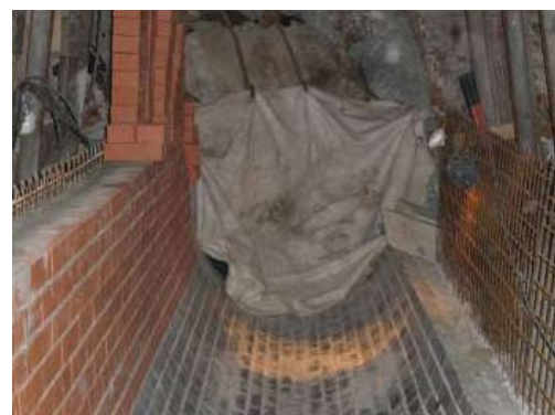
Obr. 10 Výstavba propoje do stoky „K“
