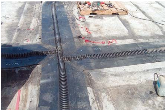
Fertiges System (werkseitig vorgefertigtes Formstück einschl. der bauseits durchgeführten Stumpf-Vulkanisationen) vor dem Aufbringen der Flächenabdichtung. Finished system (factory-made moulding together with butt joint vulcanization on site) before application of the surface sealing.
