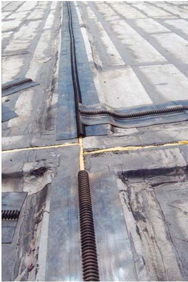
Situation vor der Vulkanisation der Stumpfstoße, Meterware bereits verlegt. Before vulcanization of the butt joints, cut-length waterstops already laid.
