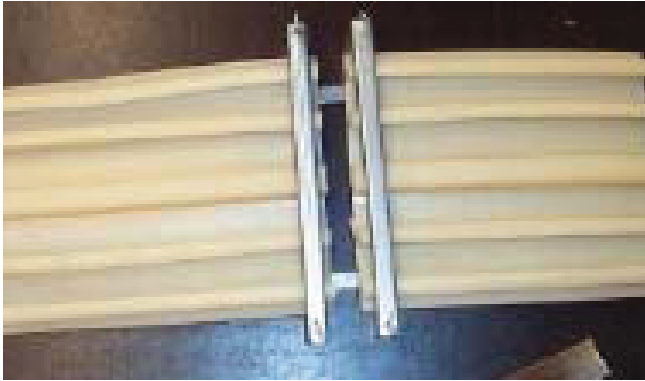
I. Fugenband einlegen. Insert waterstop ends.
