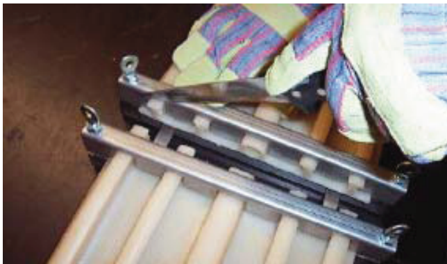
II. Mit einem scharfen Messer einen geraden, sauberen Schnitt an den zu verbindenden Fugenbandenden vornehmen. Anschließend die Profilenden so festsetzen, dass beidseitig ca. 10 mm Fugenband an der Matrize übersteht. Using a sharp knife, cut both ends to be welded straight and square. Then locate waterstop in jig, with approx. 10 mm protruding.
