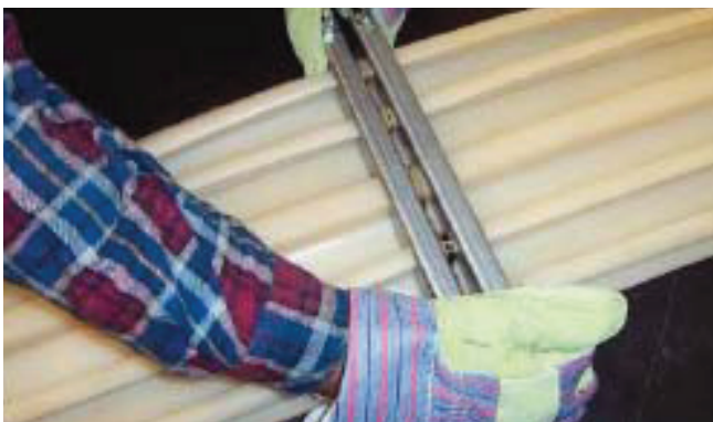
IV. Fugenbandenden ca. 2 Minuten zusammendrücken. Push molten ends of waterstop together.
